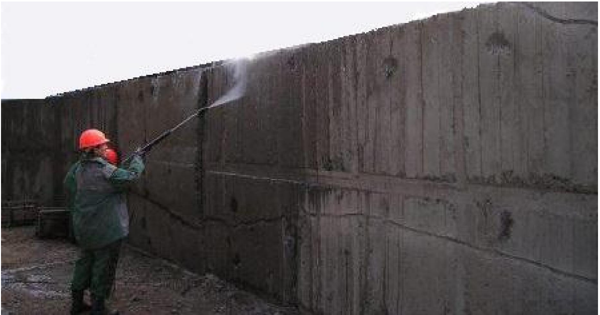
Рисунок 4.2 – Очистка и смачивание поверхности водой с помощью гидромонитора
