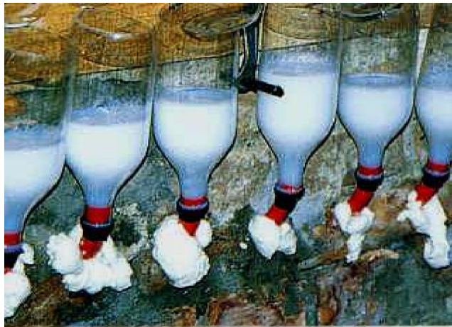
Рисунок 4.10 – Инъекция гидрофобизатора Г-84 без давления
