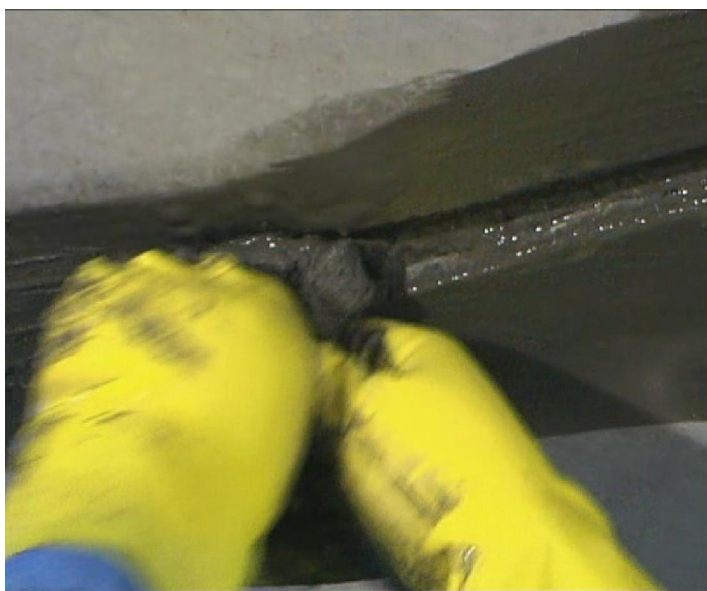
Рисунок 4.5 – Нанесение «ГС Пенетрат Шов» вручную
