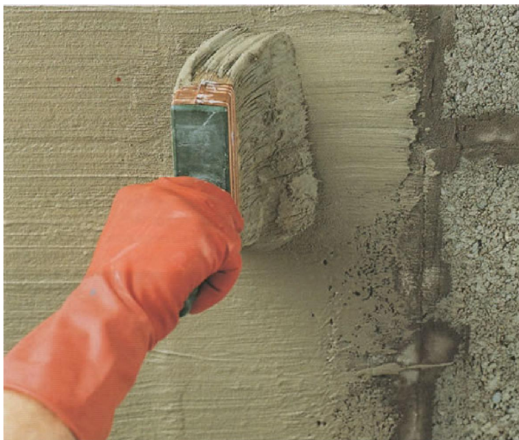
Рисунок 4.4 – Нанесение состава «ГС Пенетрат» кистью
