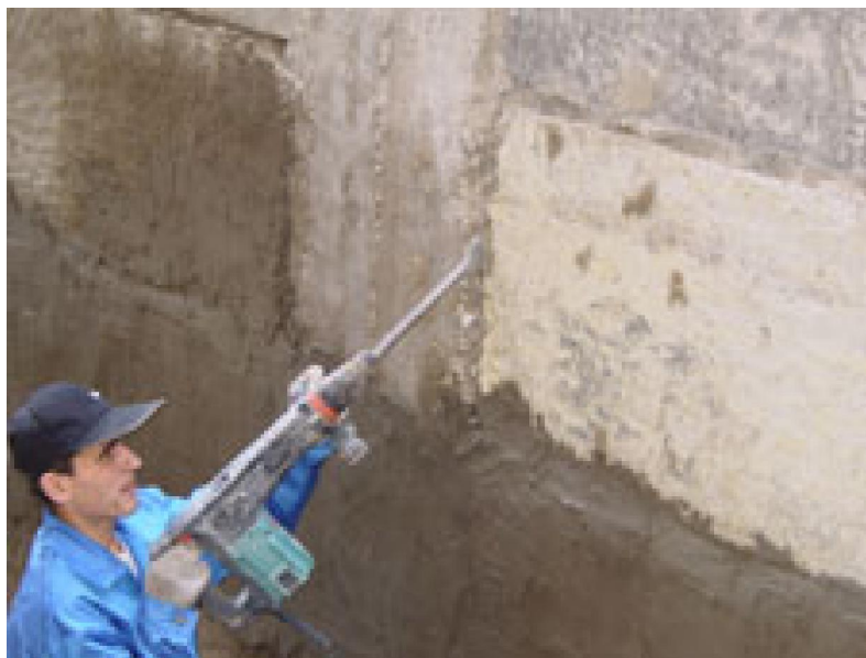
Рисунок 4.1 – Расшивка шва электроперфоратором
